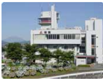
写真はアジサイに囲まれ、富士山を望む弊社本社です。
